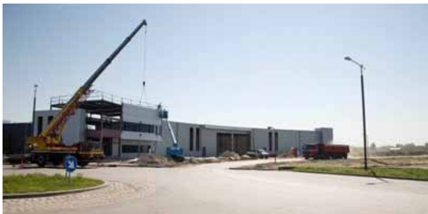
Foto van het bedrijvenpark Drachten, A7-Noord in aanbouw
